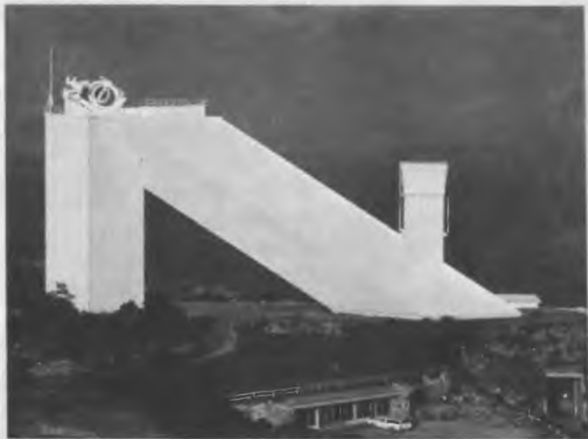
Рис. 7.7. 1,5-метровый солнечный телескоп обсерватории Китт Пик. Специальное зеркало, установленное наверху, отражает солнечный свет вдоль наклонной трубы.
